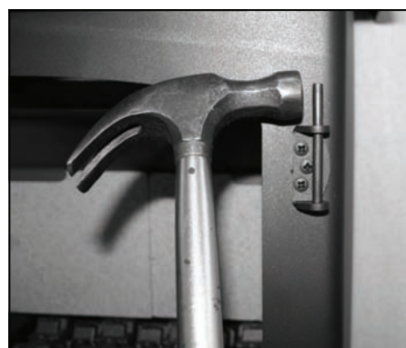
Fig. 6. Adjusting The Door Hinges
